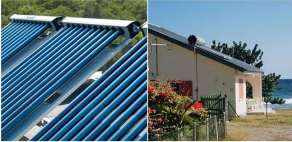
Solaire thermique pour la production d'eau chaude
